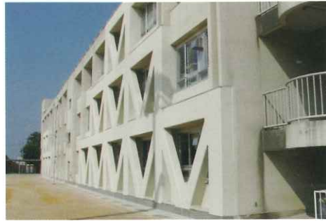
校舎の耐震工事<西宇治中学校>
