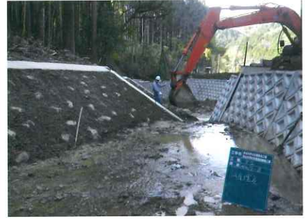
洪水を防ぐ河川の護岸工事<志津川>
