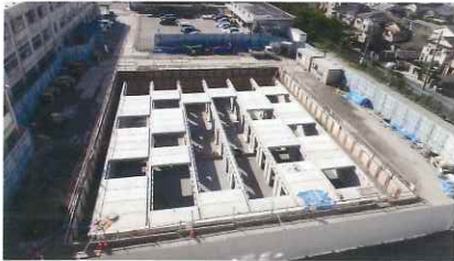
③ 雨水貯留施設工事<西宇治中学校>
