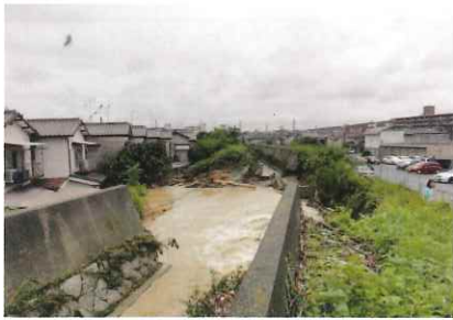
① 弥陀次郎川の堤防が決壊し、住宅地に川の水が浸入し、家屋が浸水
