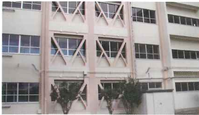
① 耐震工事<木幡中学校>
