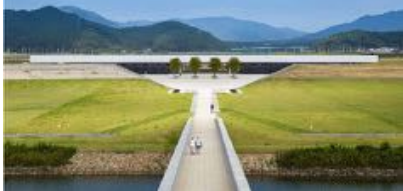
東日本大震災津波伝承館
