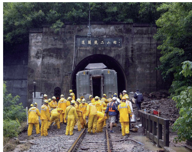
▲ 圖 5-1 南迴鐵路邊坡崩塌造成自強號出軌中斷
