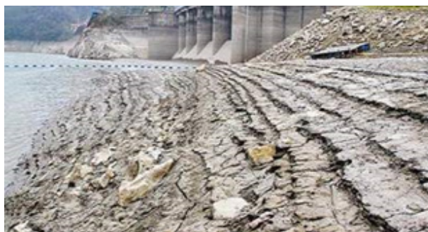
▲ 圖 6-3 乾旱地區地面龜裂
