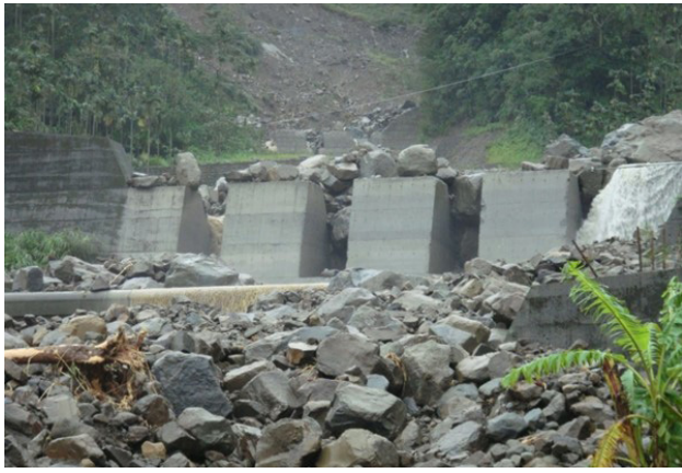
▲ 圖 5-11 2009 年莫拉克颱風期間，華山溪梳子壩攔阻土石流所夾帶的大塊石
