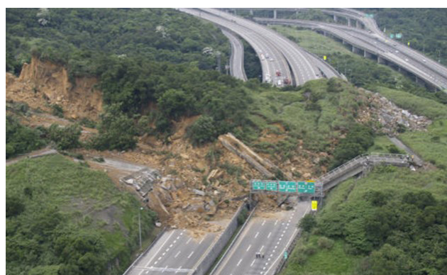
▲ 圖 5-8 國道 3 號七堵順向坡滑動災害
