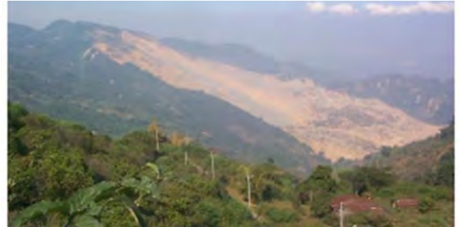
▲ 圖 5-5 九份二山大規模坍塌
