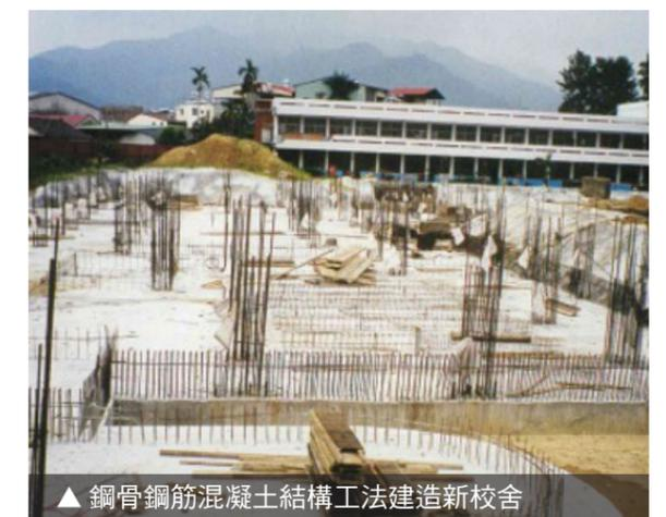
▲ 鋼骨鋼筋混凝土結構工法建造新校舍
