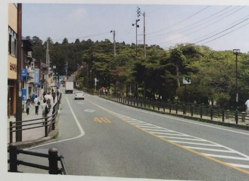
国道45号線グリーン広場前・復旧後
