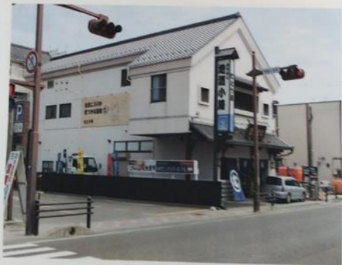
国道45号線「五大堂」前の店頭・復旧後
