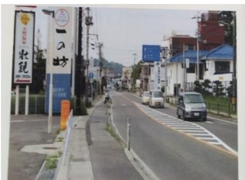
第一小学校前・復旧後
