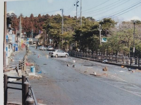
汚泥とガレキが散乱する国道45号線（グリーン広場前） Route 45 where sludge and rubble are scattered. (Nearby Green Area)
