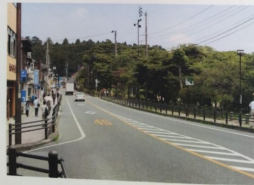
国道45号線グリーン広場前・復旧後
