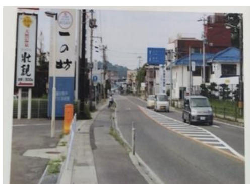
第一小学校前・復旧後
