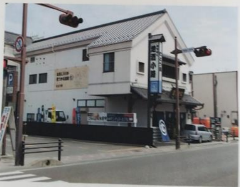
国道45号線「五大堂」前の店頭・復旧後
