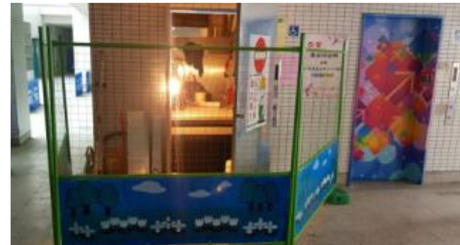
工地安全管理.警告標示
