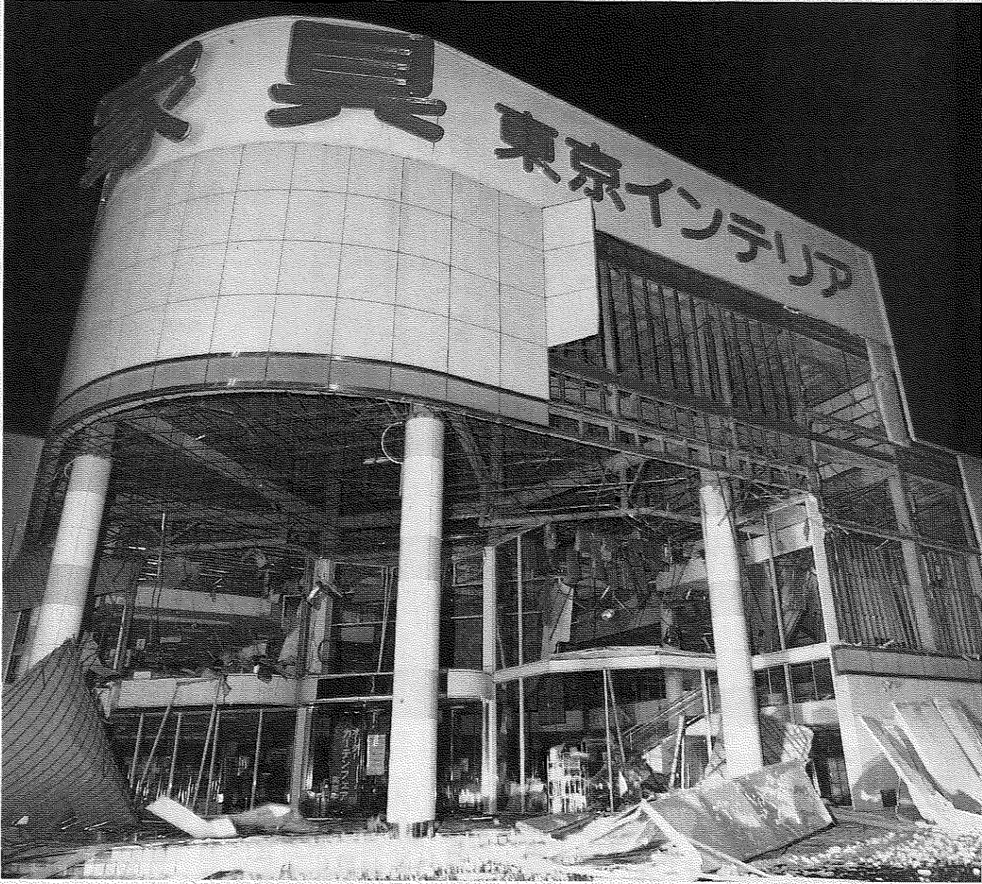
強い揺れで外壁などが崩落した家具店=11日午後6時30分ごろ、仙台市泉区
