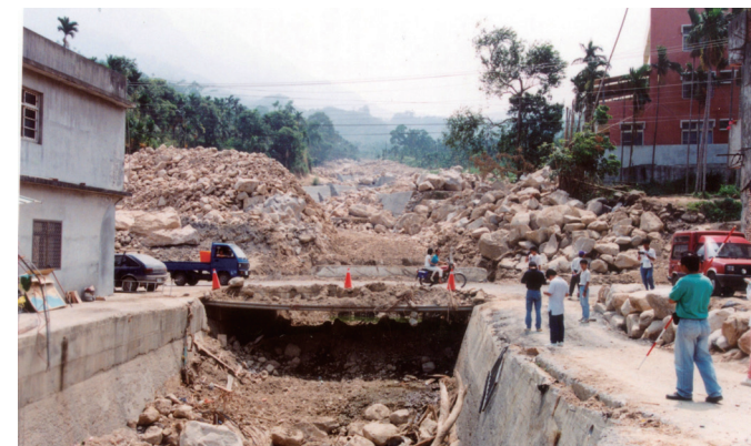
圖 8 賀伯颱風土石流災害臺 21 線公路郡坑 2 號野溪 (圖片來源：國立臺灣師範大學林宗儀副教授提供)
