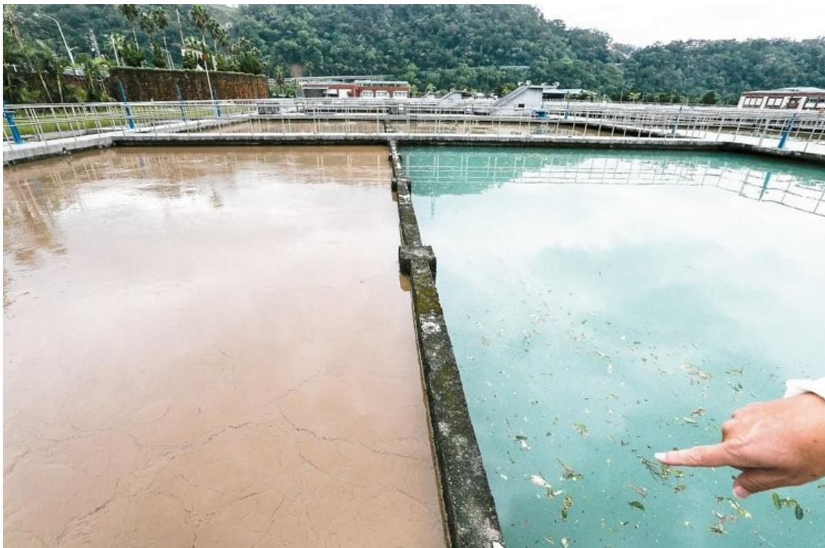
圖 28 2015 年杜鵑颱風造成臺北直潭淨水場原水濁度遽增
